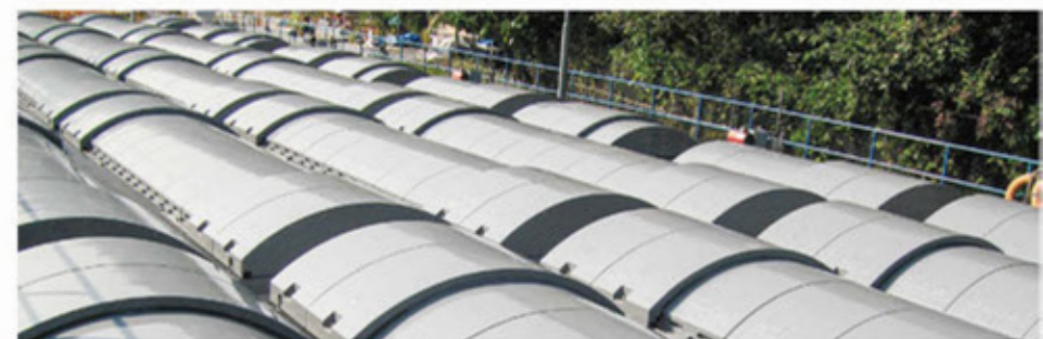
业主: 香港特别行政区水务署 项目: 为沙田污水处理厂加速沉淀池、水道和过滤池建造纤维增强复合材料覆盖工程
