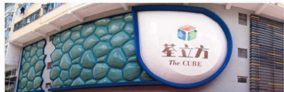
业主: 香港建时有限公司 项目: 为荃湾海福街荃立方商场建造纤维增强复合材料外立面灯光填工程
