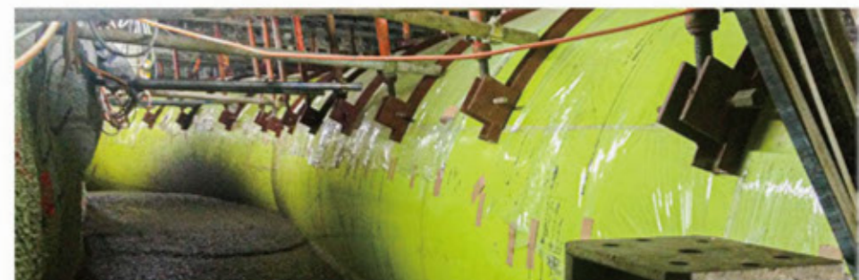
业主: 香港特别行政区水务署 项目: 为建造北角至昂船洲跨维多利亚港海底污水输送隧道工程提供纤维增强复合材料混凝土模板工程
